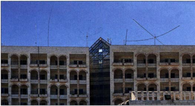
E44CC-Antennenfarm auf dem Hoteldach
